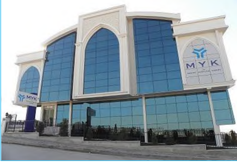
Resim 1 : MYK Hizmet Binası
